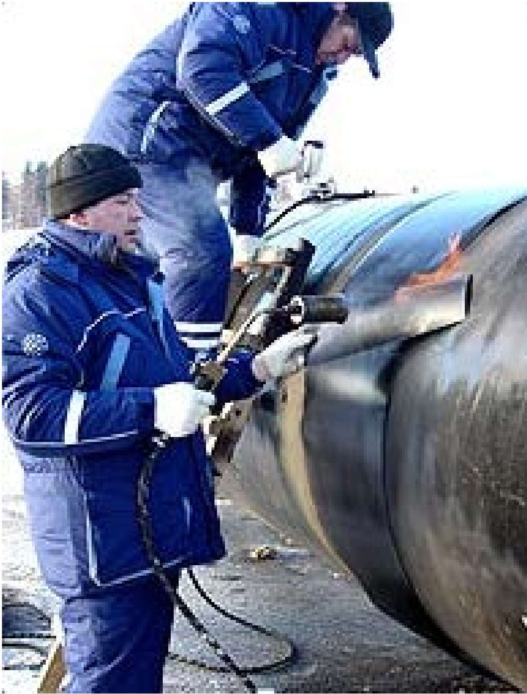
Рис.17 Установка «замка»
