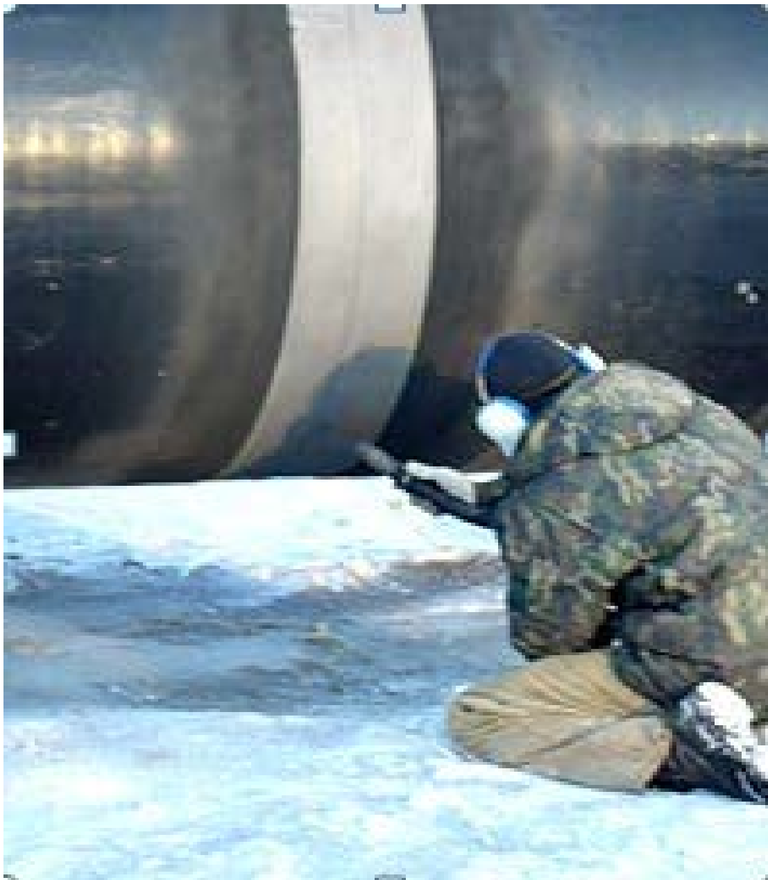
Рис.11 Очистка поверхности
