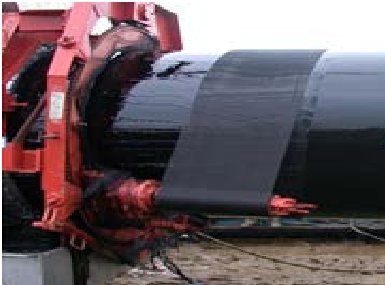
Рис.19 Нанесение защитного покрытия «Транскор-ГАЗ»
