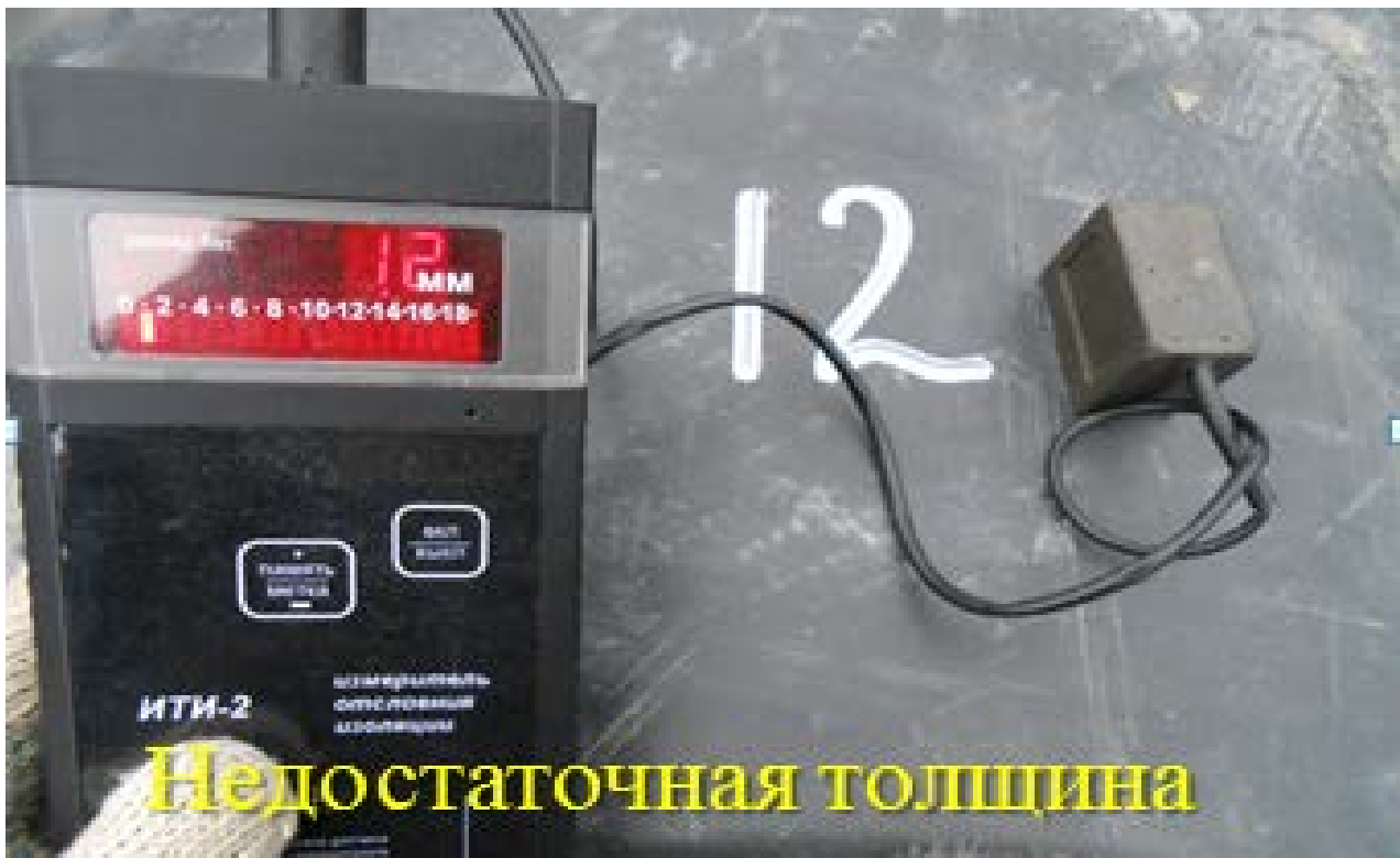
Рис.54 Недостаточная толщина защитного покрытия
