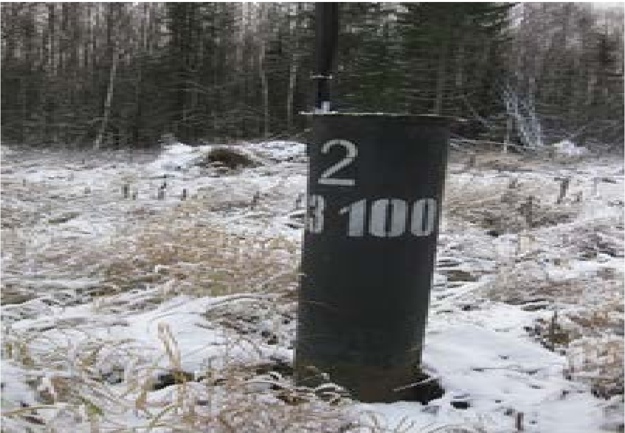
Рис.13 Глубинный анодный заземлитель ГАЗ-100
