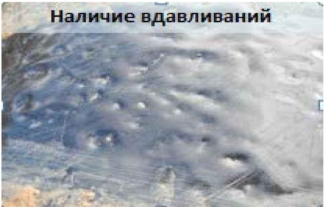
Рис.65 Наличие вдавливания
