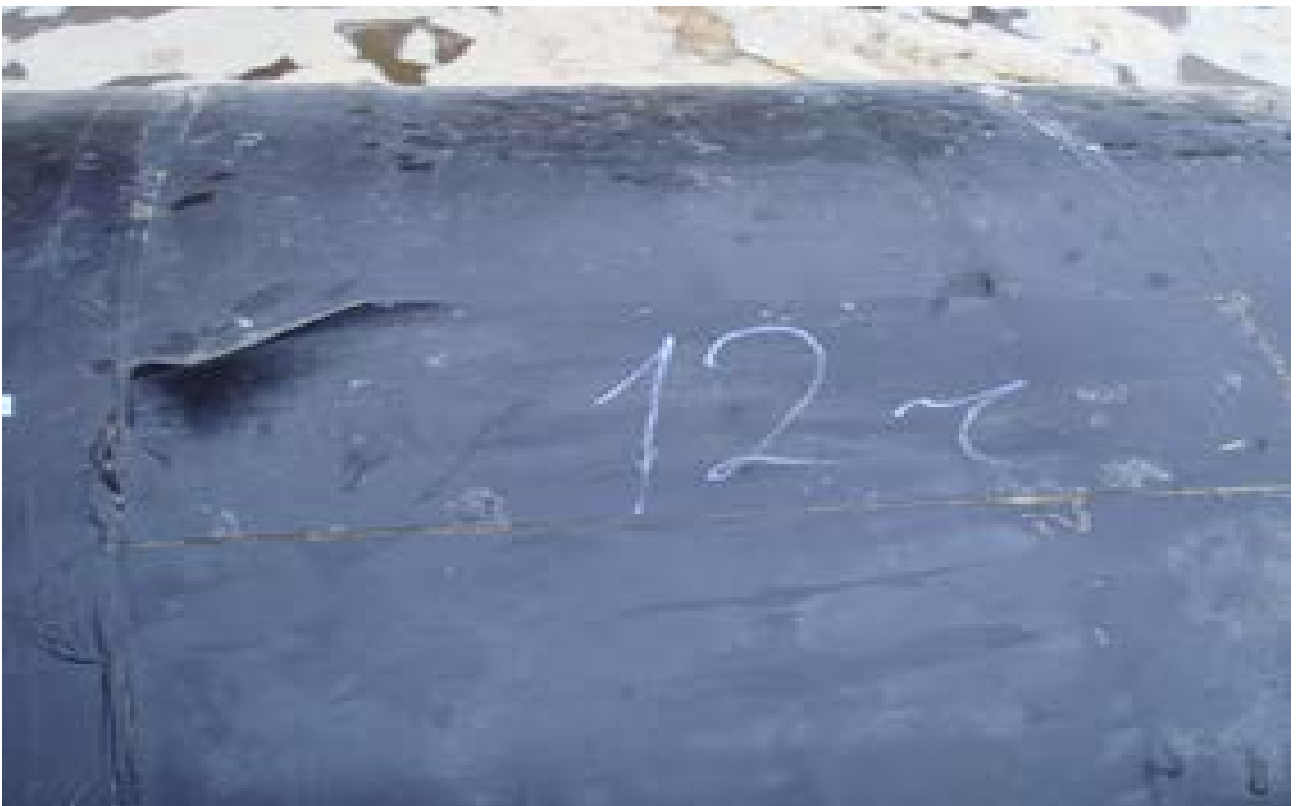
Рис.47 Брак при нанесении термоусаживающейся манжеты
