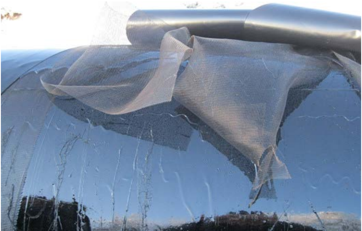
Рис.40 Стеклосетка не утоплена в мастичный слой ЗП «ТРАНСКОР-ГАЗ»
