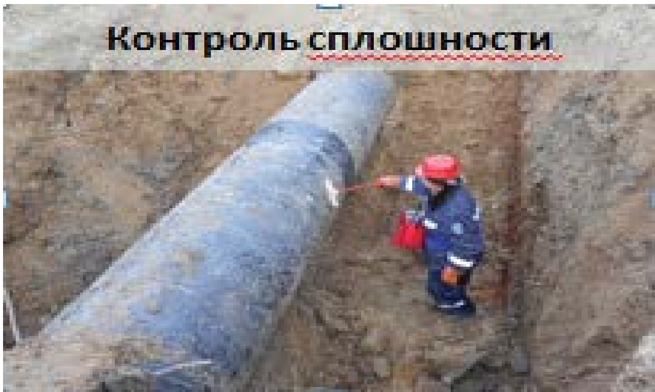
Рис.68 Контроль сплошности защитного покрытия
