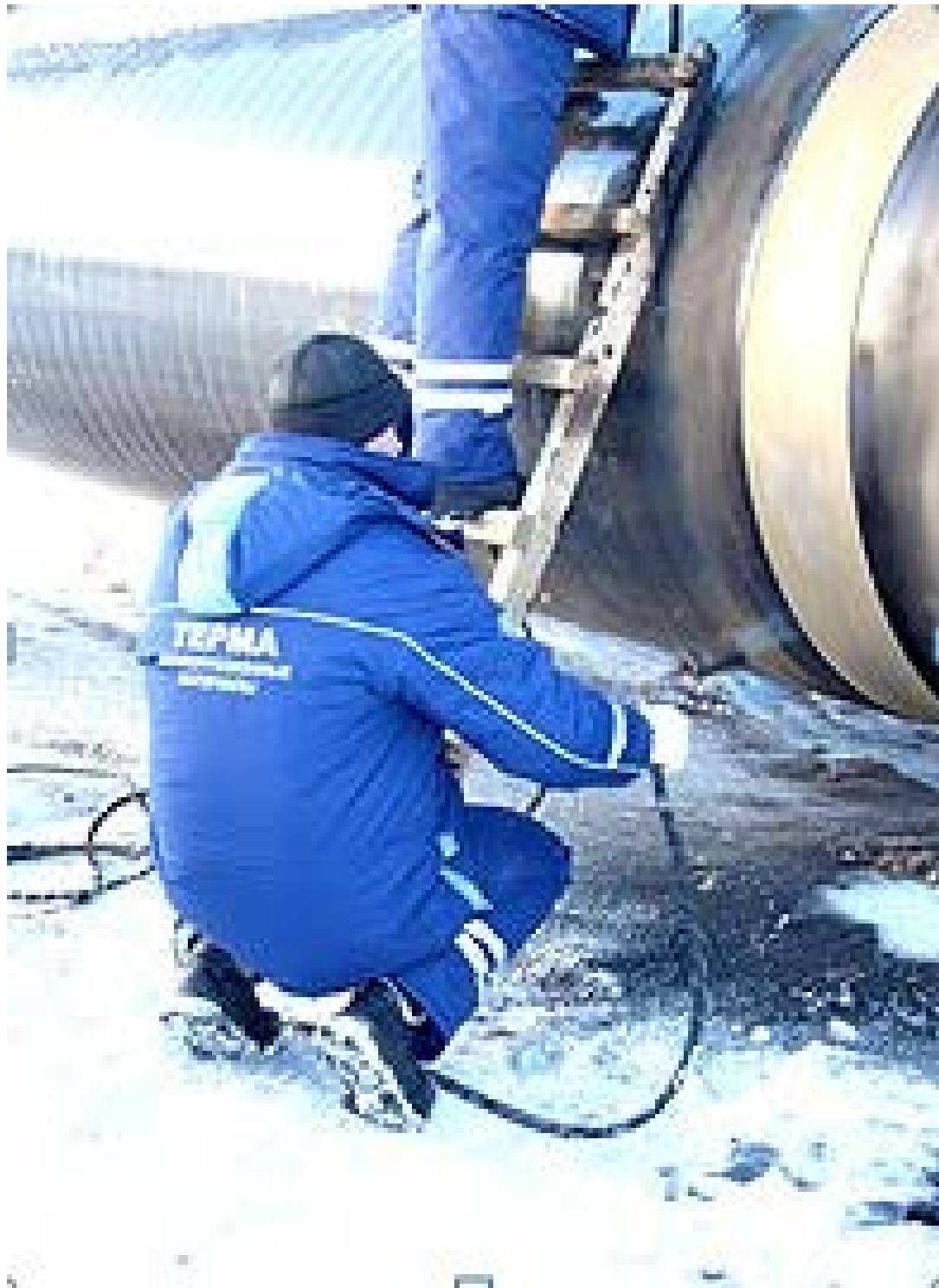
Рис.12 Нагрев поверхности
