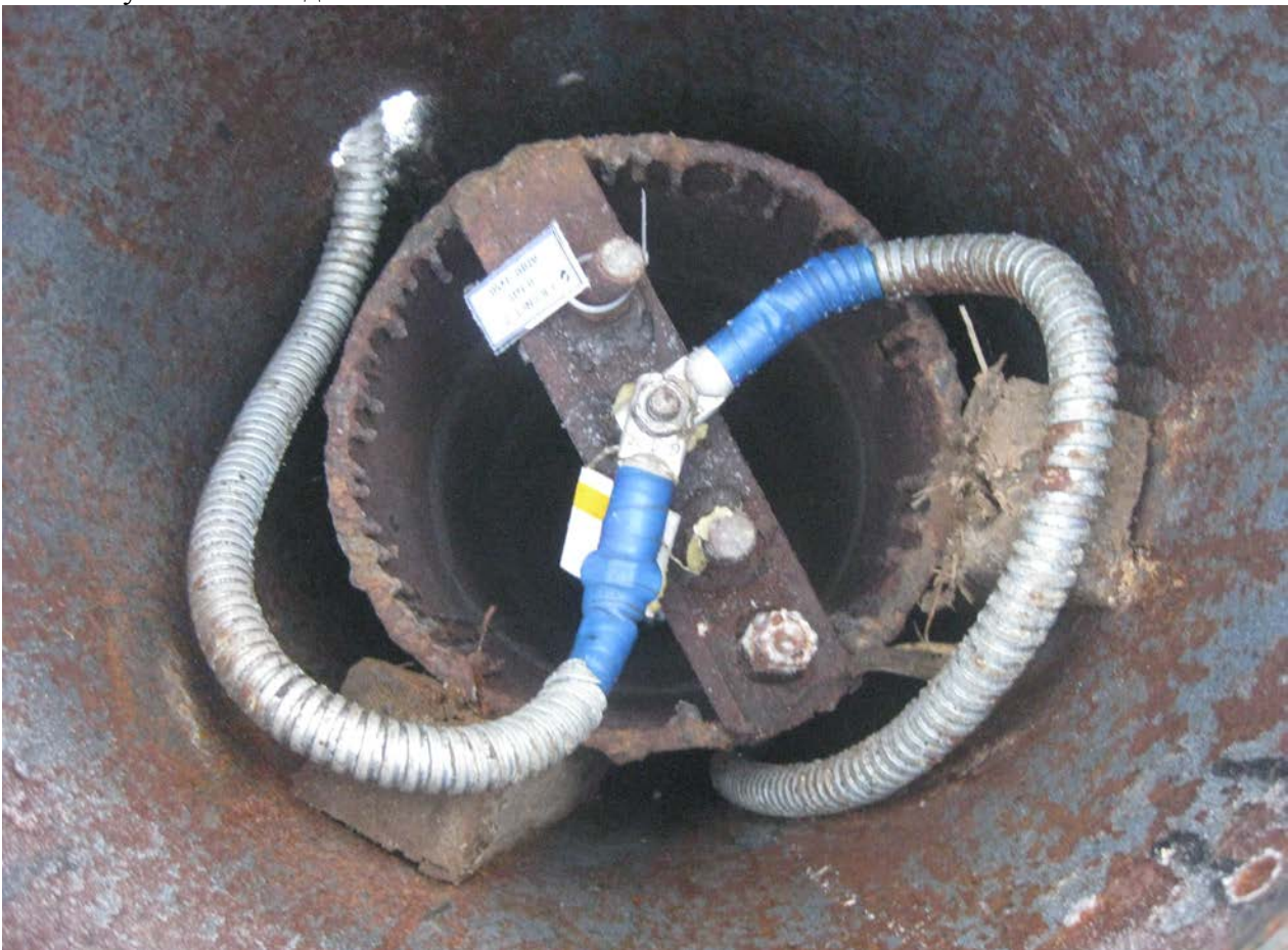
Рис.14 Крепление электрода в кондукторе анодного заземлителя ГАЗ-100
