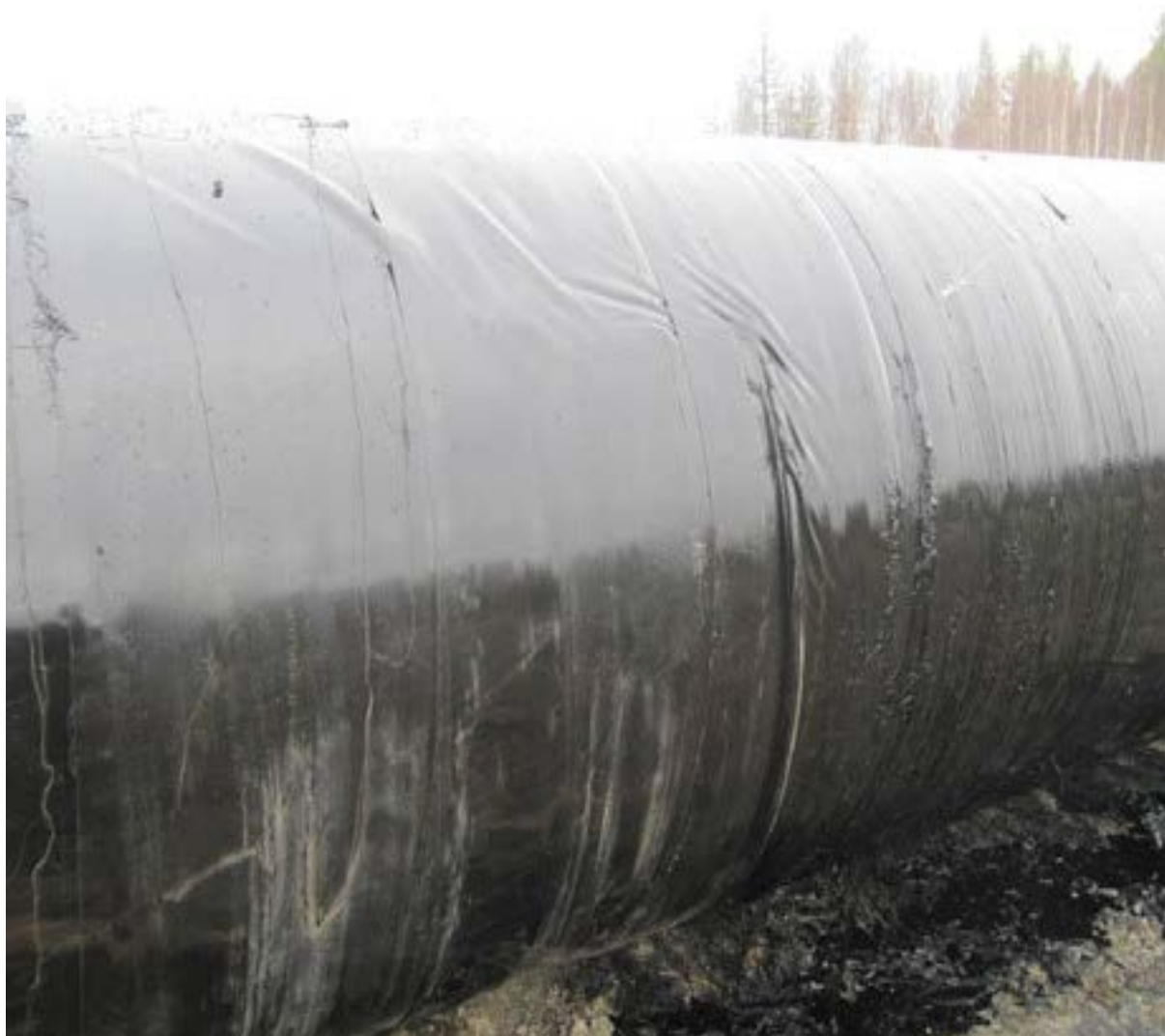
Рис.37 Гофры и складки на ЗП «ТРАНСКОР-ГАЗ»
