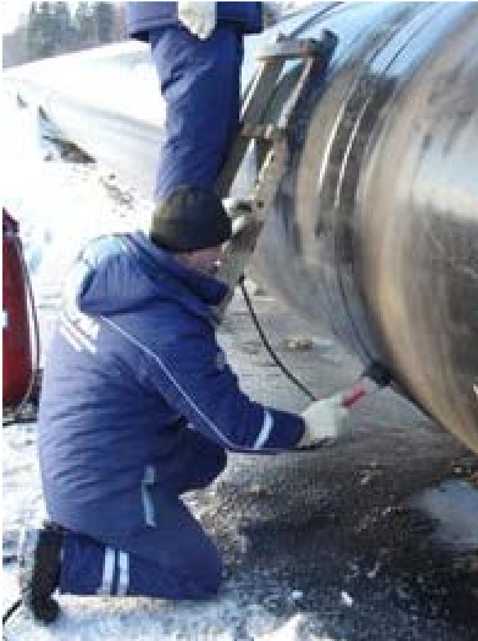
Рис.15 Нанесение праймера
